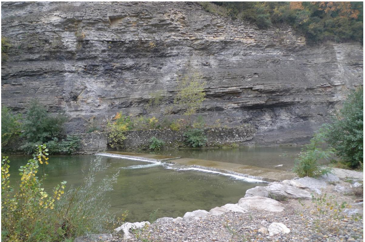
Figure 18 : Seuil de la piscine aux Fonts du Pouzin
