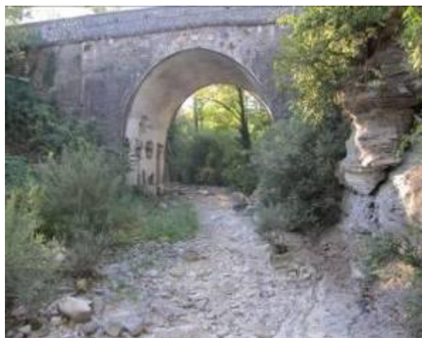
Figure 23 : L'Ouvèze au Pont des mines – Saint-Priest
